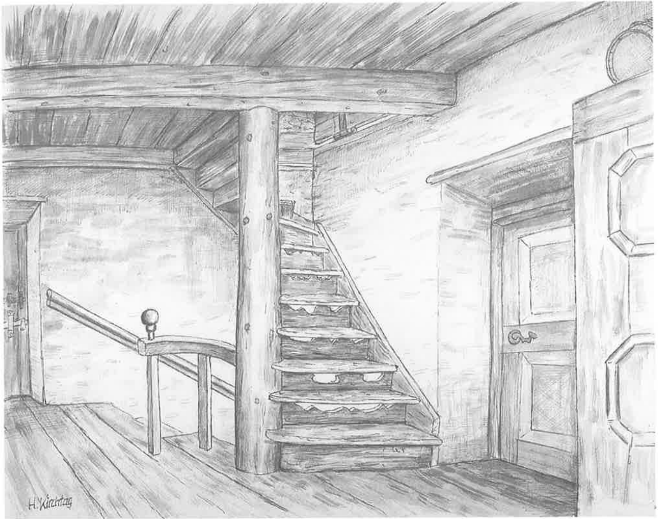
10 Die interessante Wendeltreppe zum Dachboden beim Webergut in Strohwohln.
