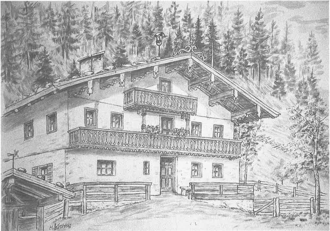
24 Das Sodergut in Unken, einer der ältesten Erbhöfe im Land Salzburg, wird erstmals in der Mitte des 14. Jahrhunderts erwähnt. Das alte Bauernhaus brannte 1721 ab. Bauzustand 1913 mit dem interessanten Giebelzeichen..
