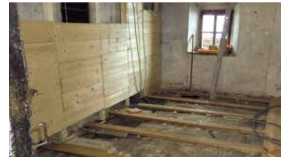
Die kleine Betriebsküche im Rohbau
