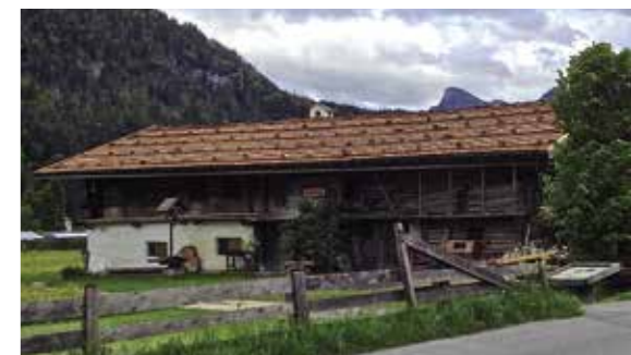
Fertig gedecktes Schindeldach
