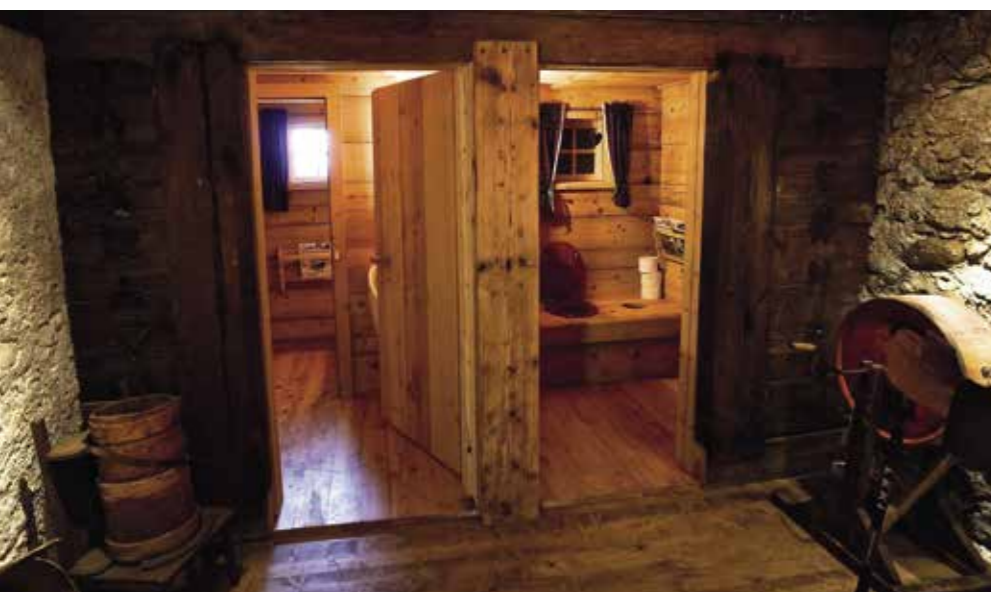
Toiletten mussten installiert werden
