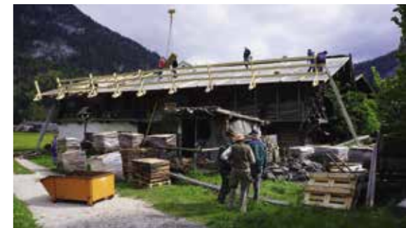
Viele Helfer bei der Dachreparatur
