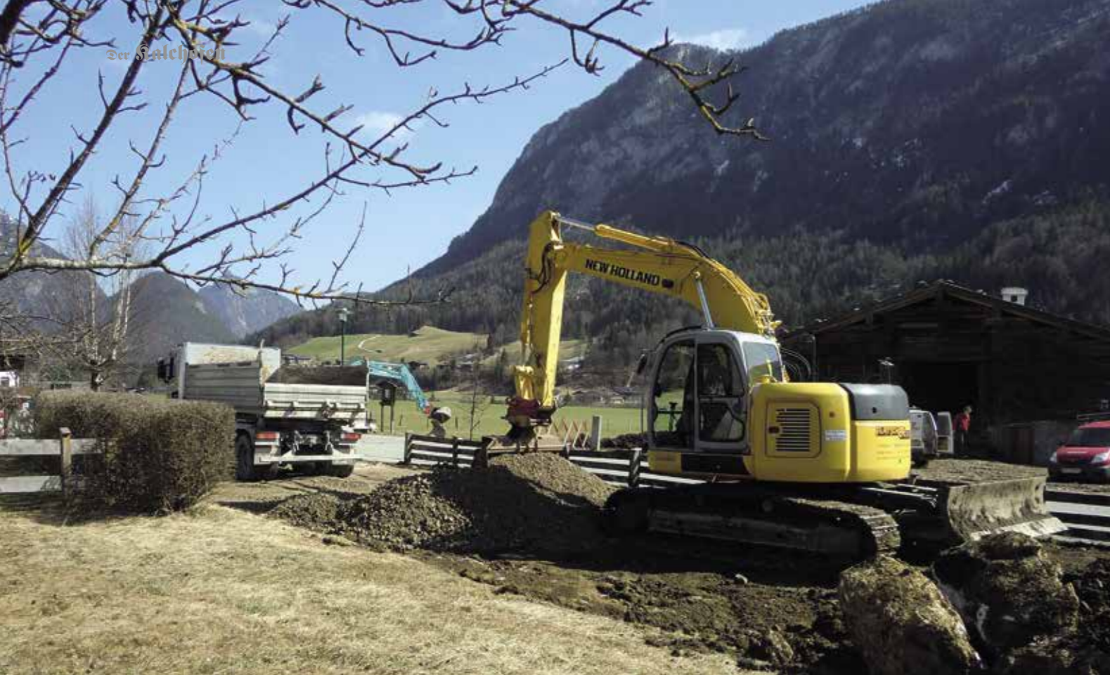
Baggerarbeiten für den Parkplatz
